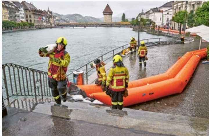
Aufbau Hochwasserschutzmassnahmen entlang des Reussufers: Installation der Beaver Schläuche
